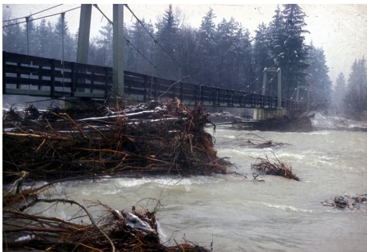
Slika 16: Primer vpliva plavja (Trnovčka brv čez Savinjo pri Spodnji Rečici)
