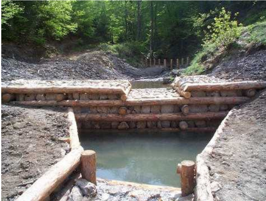
Slika 10: Manjša zaplavna kašna pregrada z grabljami za lovljenje plavja.
